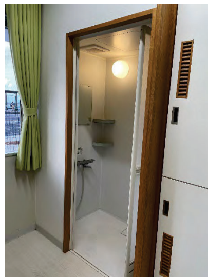
女性専用仮眠室内にユニットバスを整備
